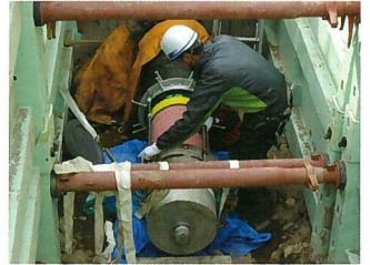
施工例（上水道工事）
