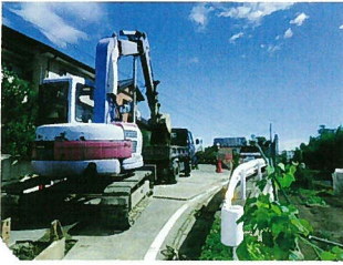
施工例（下水道工事）
