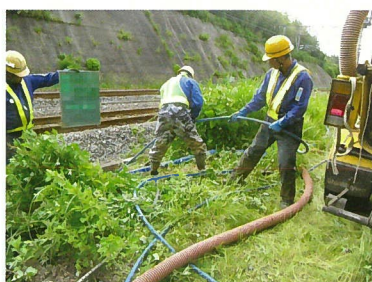
施工例（しゅんせつ）
