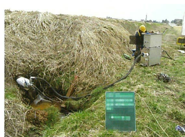
施工例（ライニング）
