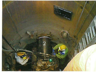
施工例（下水推進工事）
