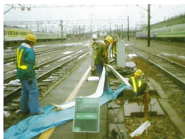
施工例（ライニング）
